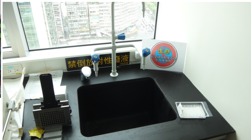
非放射性廢水槽 嚴禁傾倒放射性廢液
