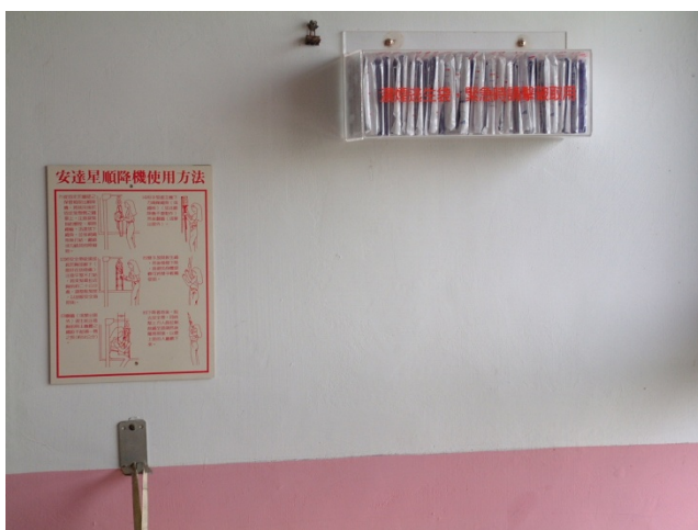
廣設濃煙逃生袋於各實驗大樓公共走道 (濃煙逃生袋與消防逃生設施合併放置情形)
