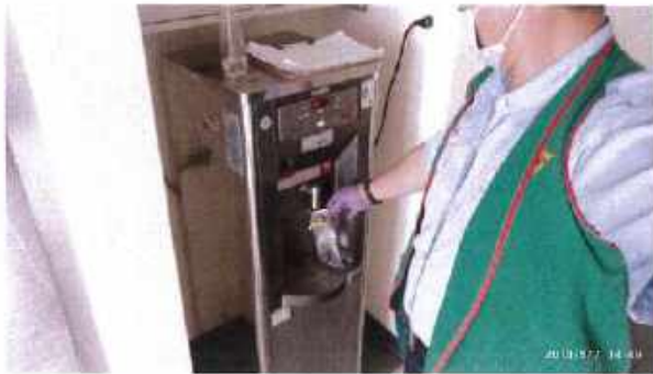
志道樓 2F 志道樓
