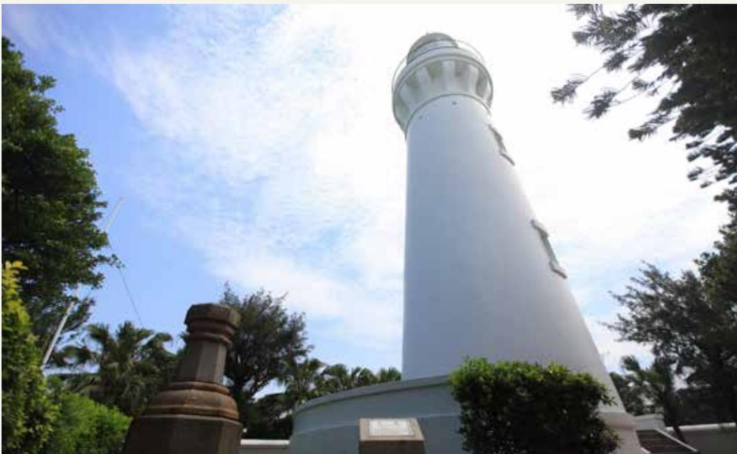
◆ 白沙岬燈塔是一座煉瓦石造雙層磚石燈塔。該燈塔之燈器為法國製三等旋轉透鏡三重芯煤油燈，塔高 37 公尺，為臺灣目前第二高燈塔。
