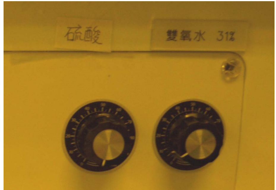
供酸系統泵浦流量調整旋鈕
