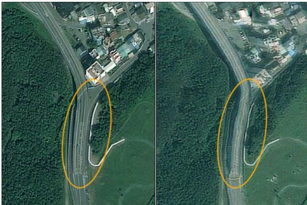
七星潭大橋災前（左）及災後（右）超高解析Pléiades衛星影像監測，由衛星圖上可見橋面有明顯錯動與斷裂。圖太遙中心提供
